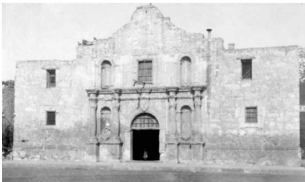
El primer impedimento que encontró el general Santa Anna fue una pequeña guarnición tejana que se hizo fuerte en una misión franciscana abandonada de la ciudad de San Antonio, llamada San Antonio de Valero, erigida hacia 1718 y transformada en la fortaleza de El Álamo en 1793.
